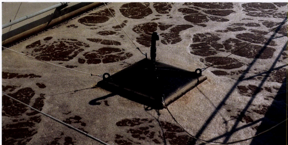
9. ábra. Úszó dinitrogén-oxid analizátor a biológiai fokozaton [6]
