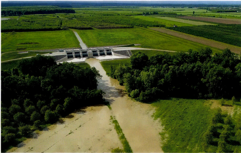
1. kép. A beregi árapasztó tározó beeresztő nagyműtárgya vízpótlási időszakban
