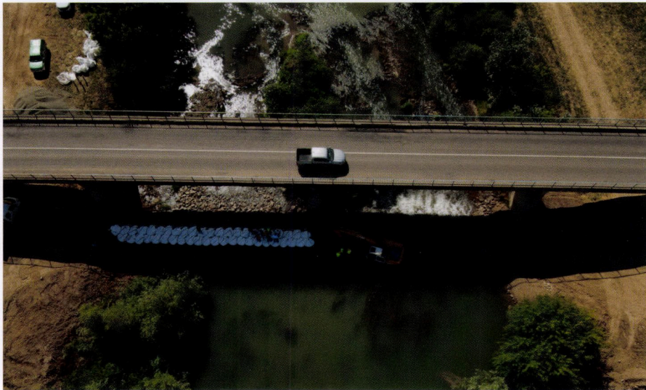
6. kép. Fenékgát építése a Sebes-Körösön a komádi hídnál
