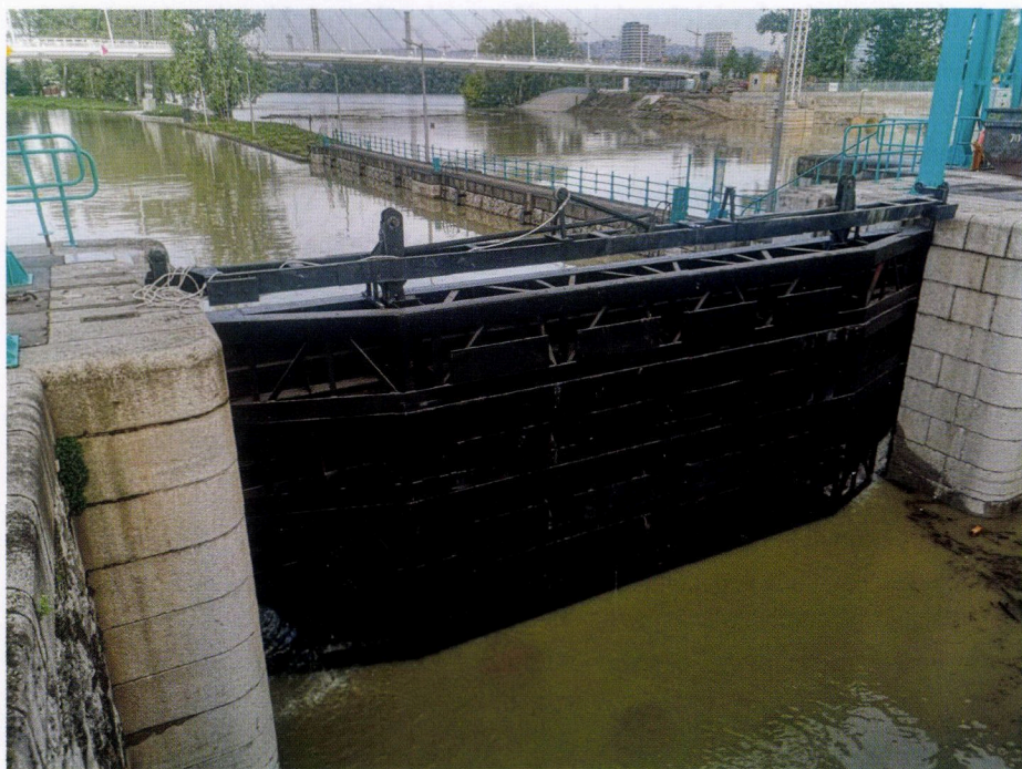
1. kép. A Kvassay vízlépcső hajózsilipje betétgerendázott állapotban
