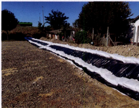
7. kép. Paks Árvíz utcai ingatlan bevédése (a KDTVIZIG archívumából)
