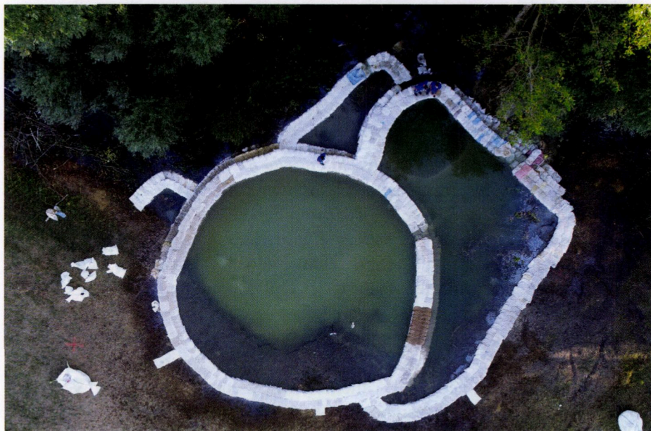
3. kép. A Patkányosi buzgár az ellennyomó medencék kialakítása után (2024.09.21.)
