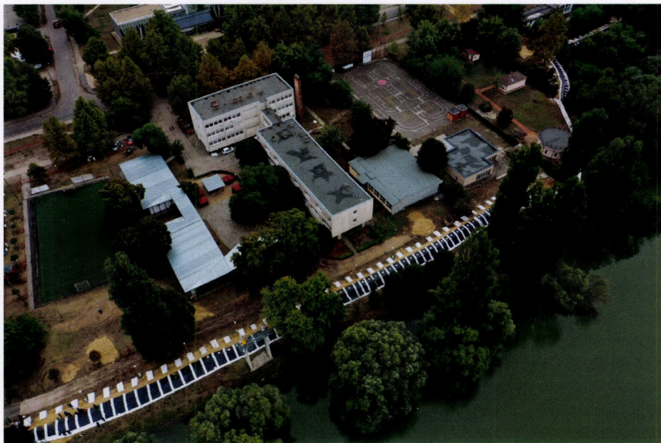
9. kép. Ideiglenes árvízvédelmi mű – Baja, Petőfi-sziget
