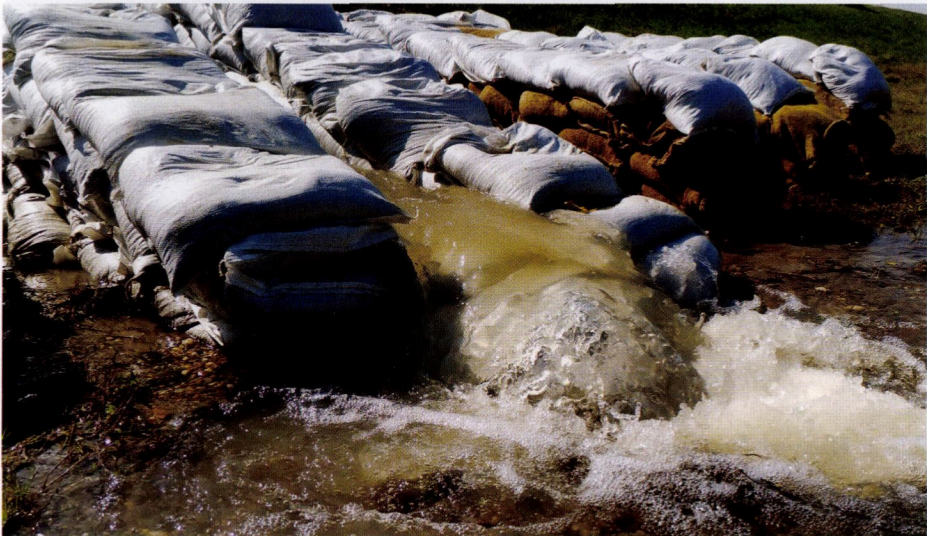
4. kép. Hódjárat miatti vízátfolyás a Lajta Balparti-csatorna balparti fővédvonal 14+500 tkm szelvényében
