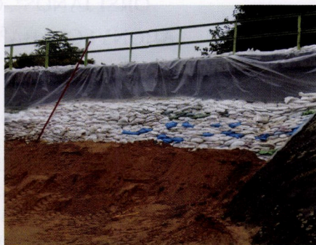
2. kép. A 4. sz. vasútvonal alatti áttörés ideiglenes elzárása a védekezés során (az ÉDUVIZIG archívumából)
