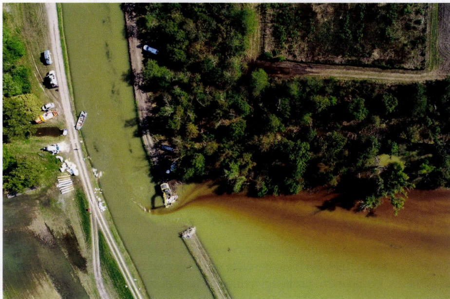
1. kép. A Lajta 1. sz. szükségátározó vízvisszavezetési helye (Balparti-csatorna 10+ 340 fkm)
