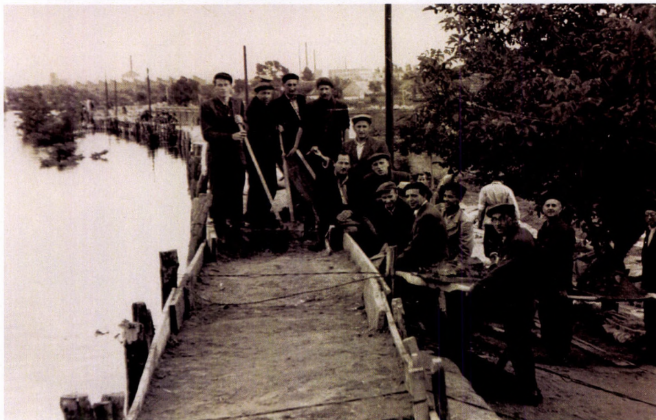
5. kép. A révfalui körgát erősítése jászolgáttal (az ÉDUVIZIG archívumából)
