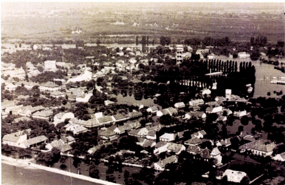
4. kép. Az elöntött révfalui víztorony környéke (az ÉDUVIZIG archívumából)
