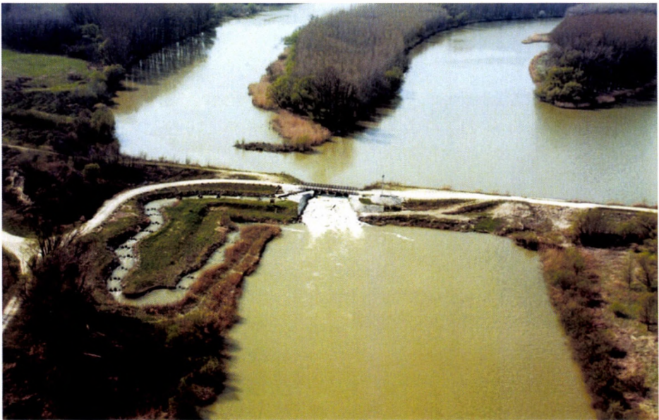
6. kép. A Denkpáli ágvéglezárásnál megépült megcsapoló műtárgy és halátjáró (Fotó: ÉDUVIZIG)
