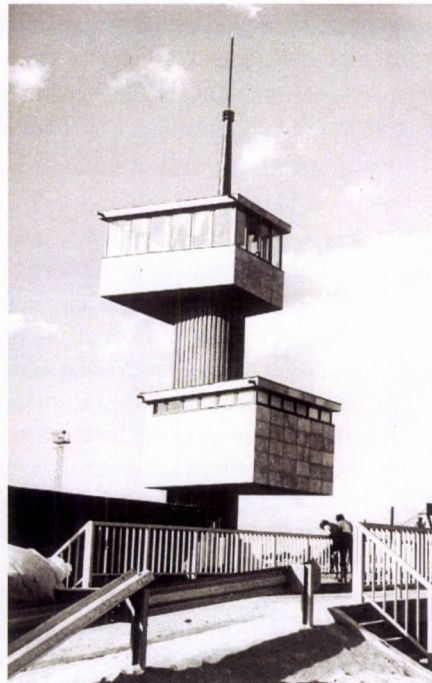
3. kép. A torkolati mű vezérlő tornya (1974) (A KDTVIZIG archívumából)
