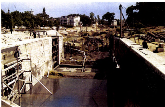
8. kép. A siófoki hajózsilip építése (1941-47) (a KDTVIZIG archívumából)
