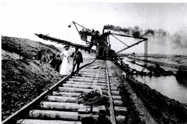
7. kép. Vedersoros kotróval bővítik a Sió csatorna medrét a 19-20. század fordulóján (Fejér 2001)
