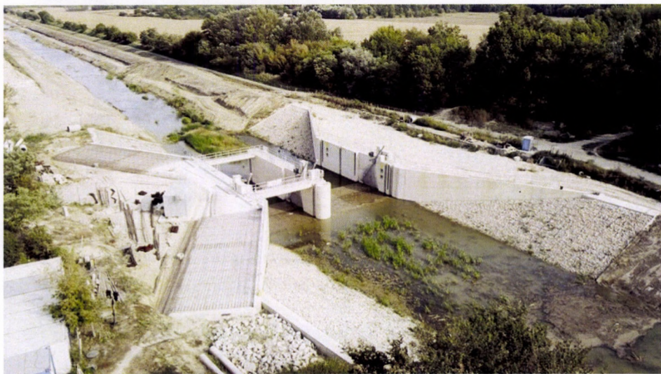
27. kép. A Balatonkiliti duzzasztó építése (STABAG Zrt.)
