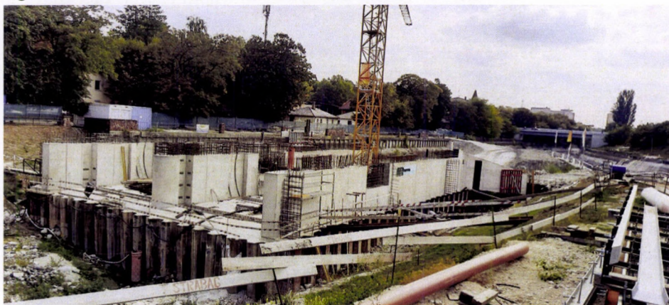
20. kép. A siófoki leeresztő zsilip építése (1) (STABAG Zrt.)
