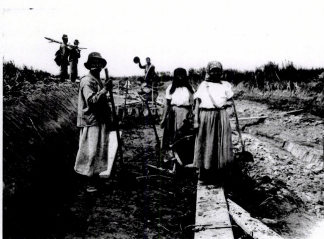
6. kép. A Sió medrének építése kubikus munkával 1910–1920 között (Fejér 2001)
