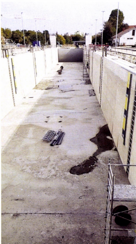
25. kép. A siófoki hajósilip építése (1) (STABAG Zrt.)
