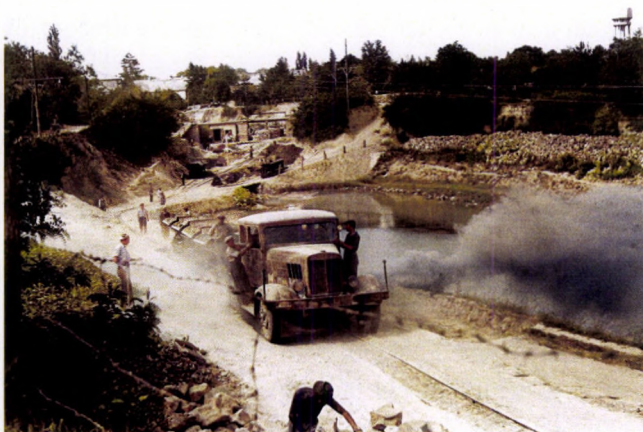
10. kép. A Sió zsilip építése, medermunkálatok, fölkihordás (1941-47) (a KDTVIZIG archívumából)
