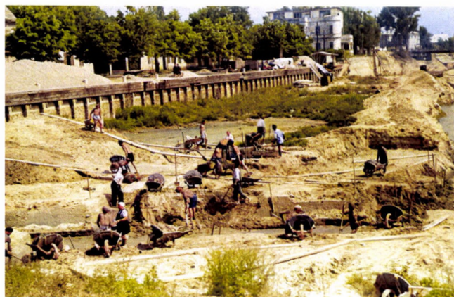
9. kép. A Sió-zsilip építése, földkihordás az alvízről (1941-47) (a KDTVIZIG archívumából)
