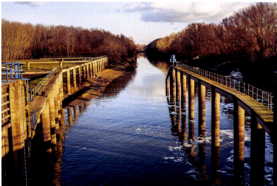
8. kép. Az alvízi vezetőmű (2022) (Ruip Gergő felvétele – KDTVIZIG)
